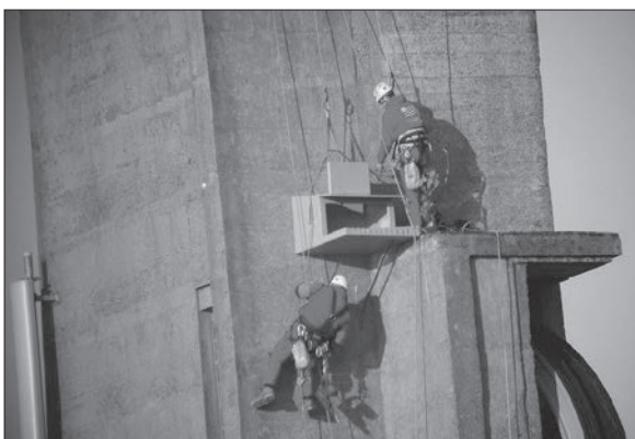
Le Pont de Recouvrance le 7 janvier 2007 (© Yvon Capitaine)
